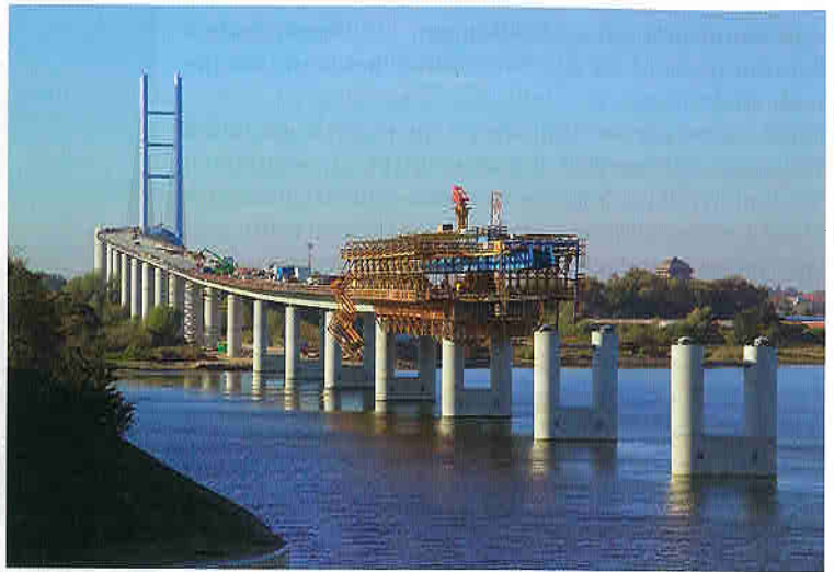
Bild 5. Vorschubrüstung Fig 5. Formwork Carriage
