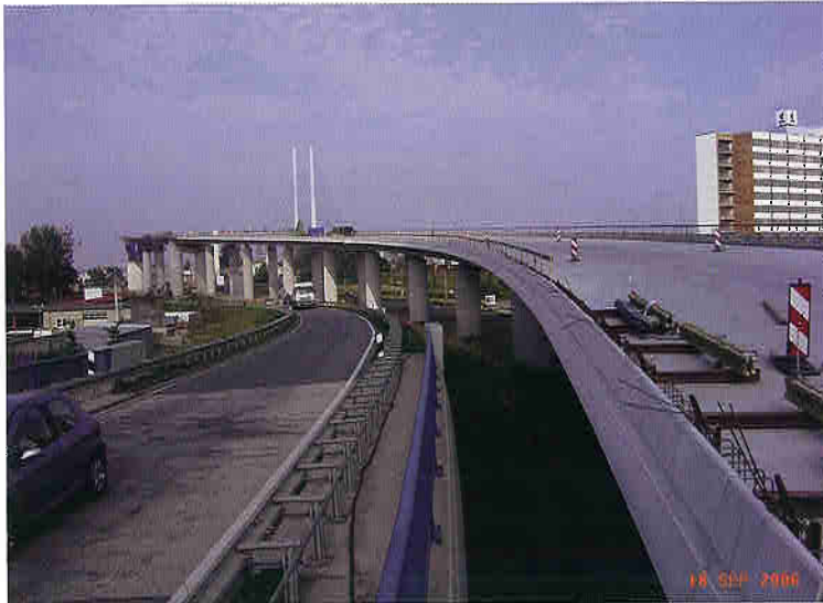
Bild 7. Montierte Fertigteilkappen Fig 7. Mounted Pre-fabricated Cantilevered Parapets
