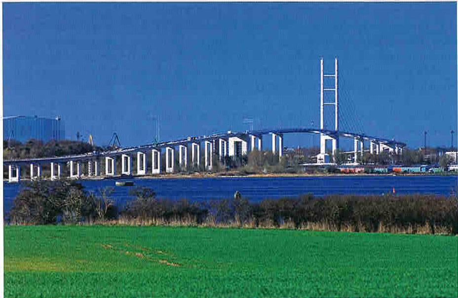
Bild 10 Aufgelöste Pfeiler Fig 10. Openwork Piers
