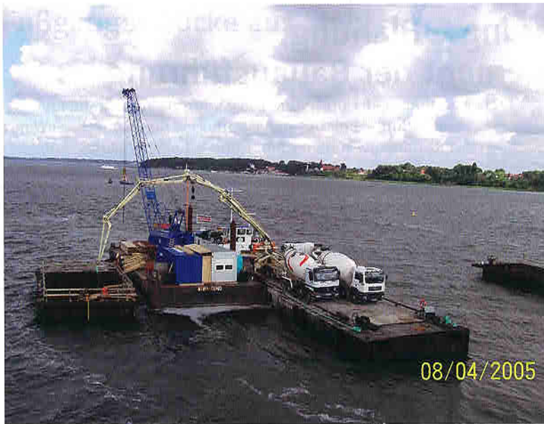
Bild 1. Ponton mit Fahrmischern Fig 1. Pontoon with Truck Mixers
