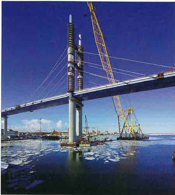
Bild 4. Montage im Winter Fig 4. Construction in Winter
