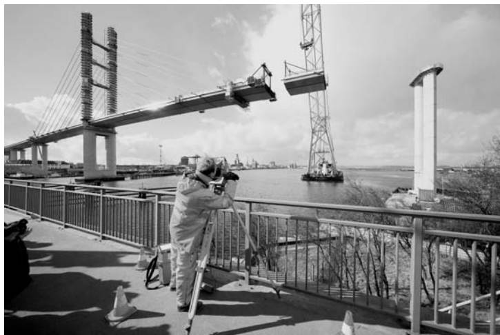
Bild 7: Montage im Freivorbau
