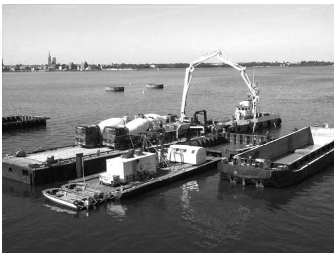
Bild 5: Betonmischer auf Ponton
