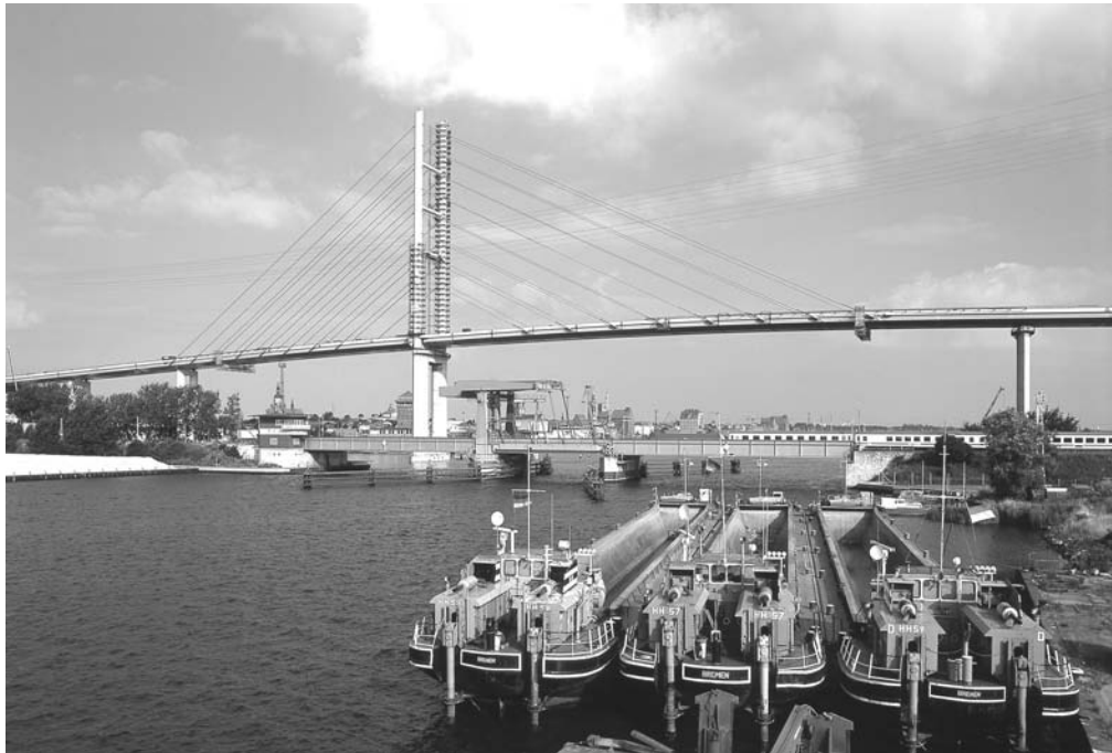
Bild 9: Bautenstand der Schrägseilbrücke im Juli 2006
