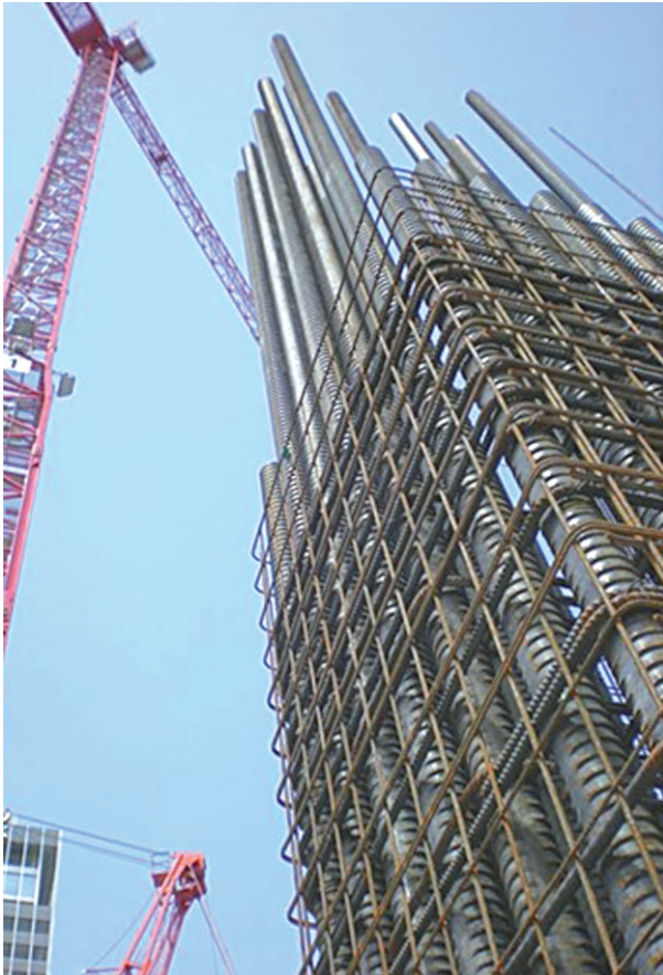
Bild 17. Komplette Bewehrung einer Megastütze des Opernturms
