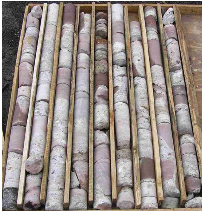
Bild 18: Bohrkern 5-3 der Kernbohrung \varnothing 80 mm der Talbrücke Kleinenbremen in Achse 5 im Bereich des Querbalkens. Das angebohrte Gefüge des Zwickelmauerwerkes unterhalb des Querbalkens ist inhomogen. Mauerwerk mit geschlossenem Gefüge wird durch z. T. haufwerksporige Schichten unterbrochen.
