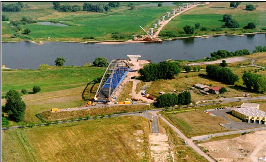
Elbebrücke Tangermünde vor dem Einschwimmen
