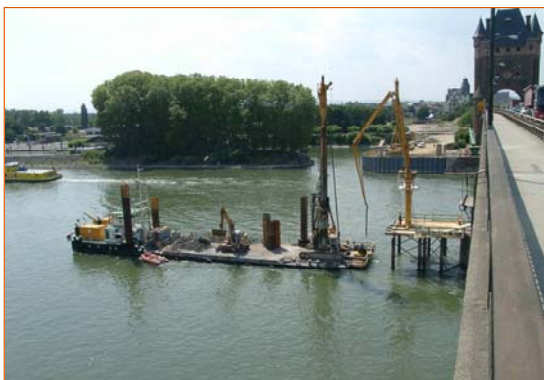
Bohrgerät auf Ponton
