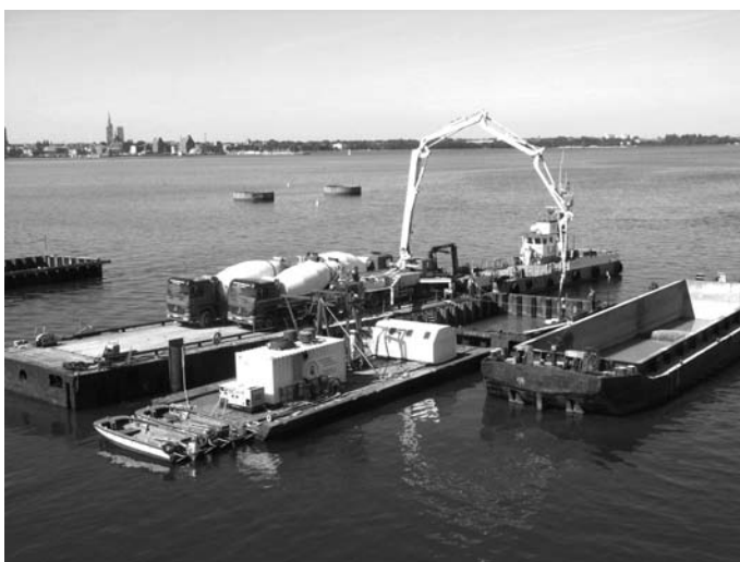
Bild 5: Betonmischer auf Ponton
